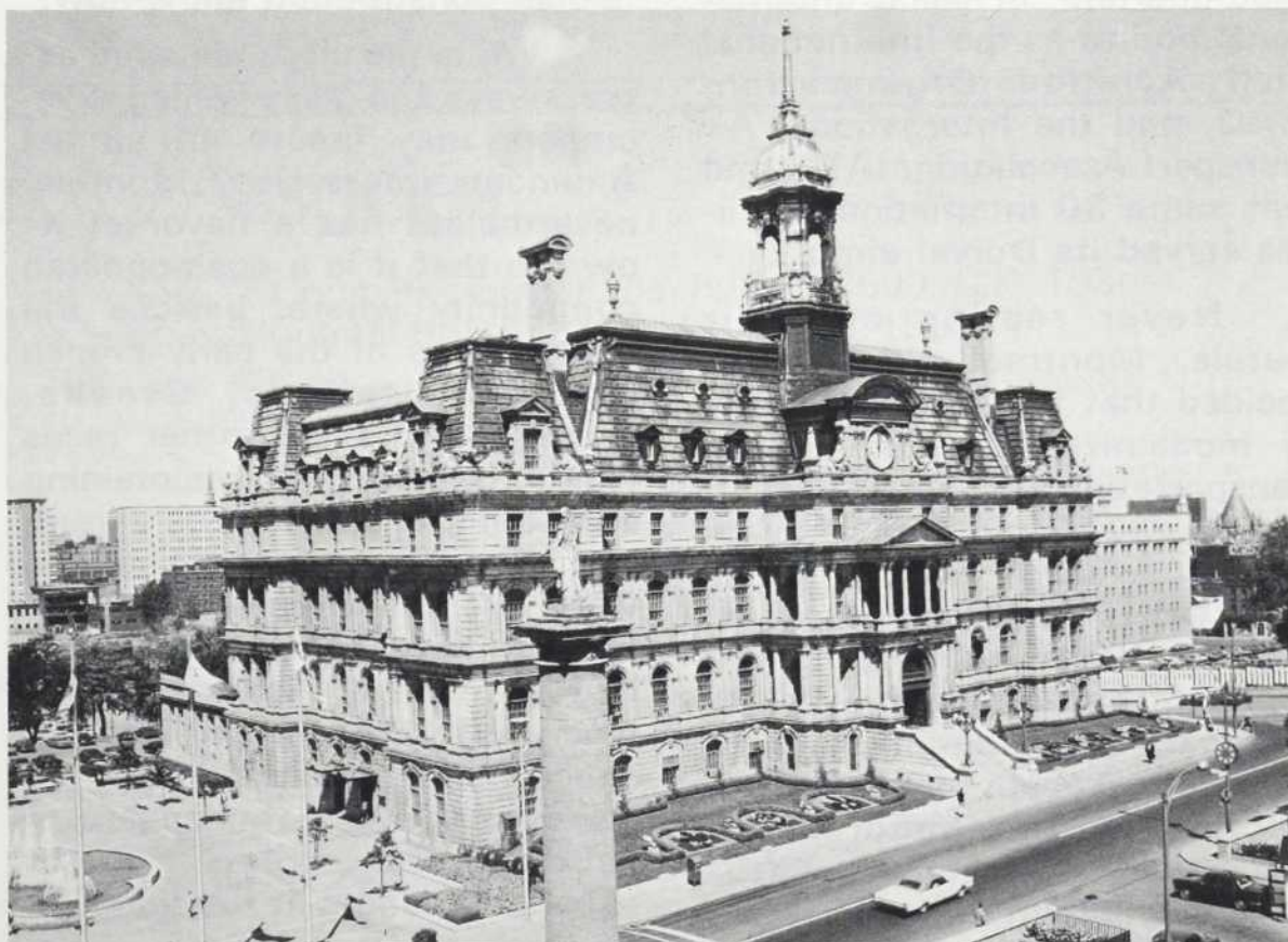
L'Hôtel de Ville de Montréal situé rue Notre-Dame Est, avec, à l'avant-plan, la colonne Nelson. Ouvert en 1878, il fut incendié en 1922 et reconstruit dans le même style.
