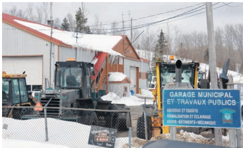
Le garage municipal actuel ne répond pas aux besoins des travailleurs de Chandler.
