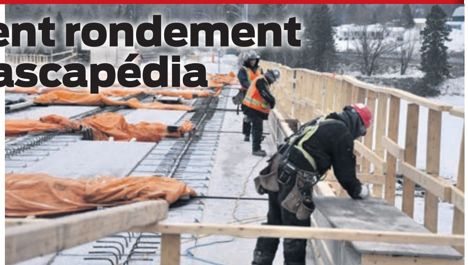
Au plus fort des travaux, plus de 20 personnes travaillaient à ce projet. (Photo Alain Lavoie)
