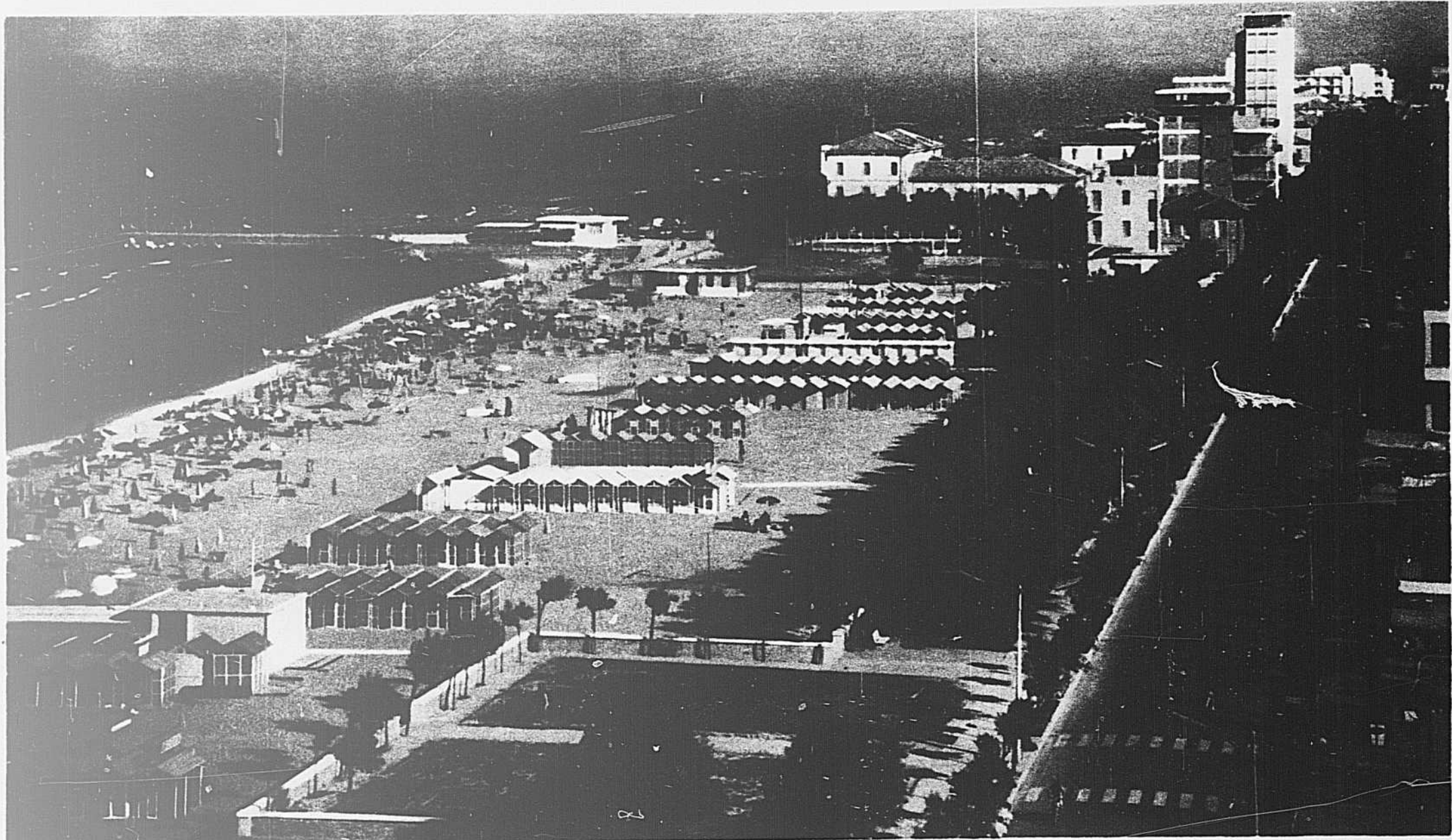
C'est à Pesaro que vécut l'illustre Rossini. La ville n'a pas que sa station balnéaire à offrir. Elle a aussi des monuments.
