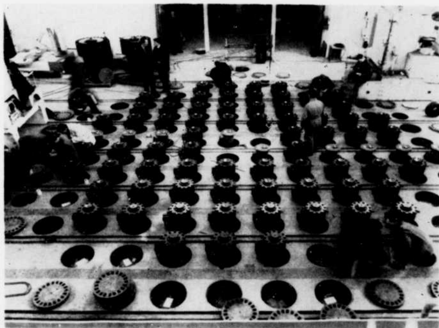
Le toit de l'un des réacteurs au dernier stade de construction.
