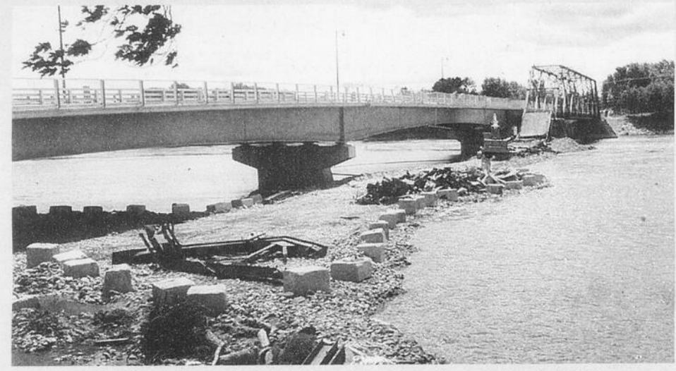
La dernière partie du pont de 1907 photographiée le 22 juillet 2008 avec les débris sur une chaussée temporaire à travers la rivière des Mille Îles. (Photo : Nicole Boisvert)
