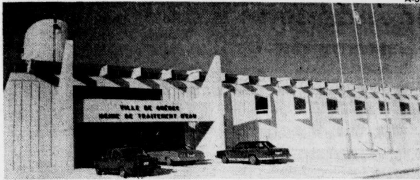
L'usine de traitement de l'eau de la ville de Québec à Château-d'Eau.
