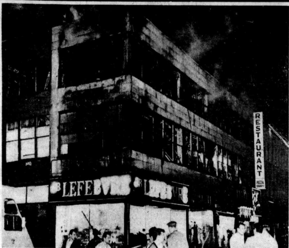
Salle de quilles détruite par le feu
