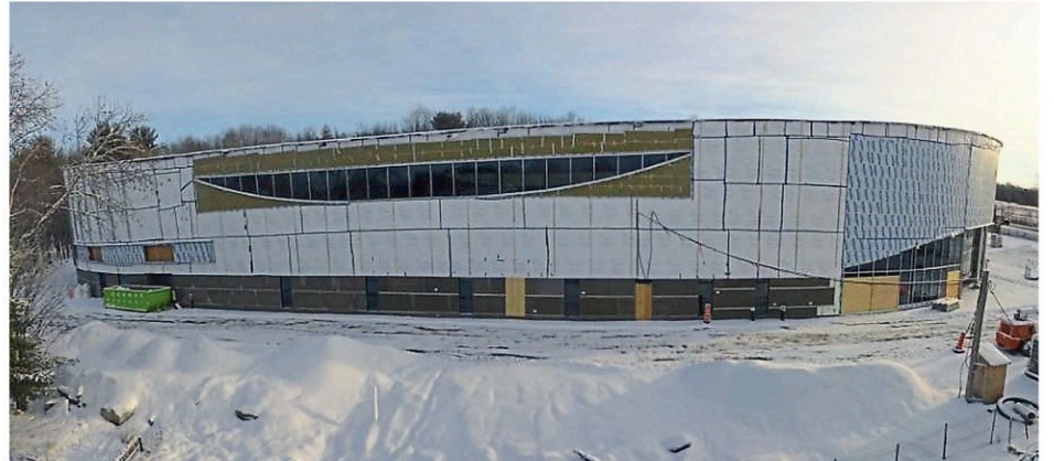
Une photo du vélodrome en construction (Photo: Facebook/Centre national de cyclisme de Bromont)
