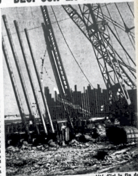
Le pilier double, No cinq, sera complété d'ici la fin de l'année 1964. Le béton sera coulé à partir du 15 décembre. (Photo Pierre Wibaut)
