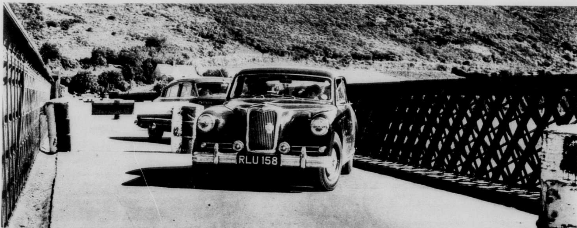
La pose d'obstacles a été une réussite et maintenant les autos ne peuvent même plus rouler à la vitesse autorisée de cinq milles à l'heure. Le pont ne risque plus rien. ✓
