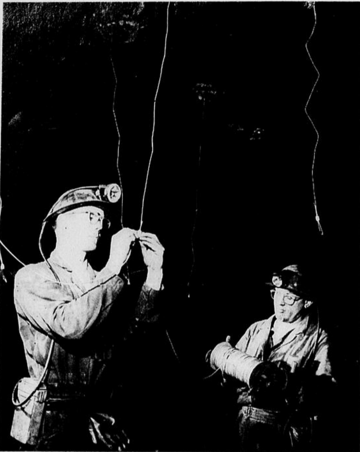
La connexion du « B-Line » au cordeau détonnant à l'une des mines de Falconbridge Nickel Mines Limited, près de Sudbury, Ont. Les techniques ordinaires de filage principal du réseau sont utilisées dans la connexion de trous de mines chargés de mélanges NA/HC et d'« Anodet » à retard, une nouvelle amorce non-électrique mise au point par la C.I.L.
