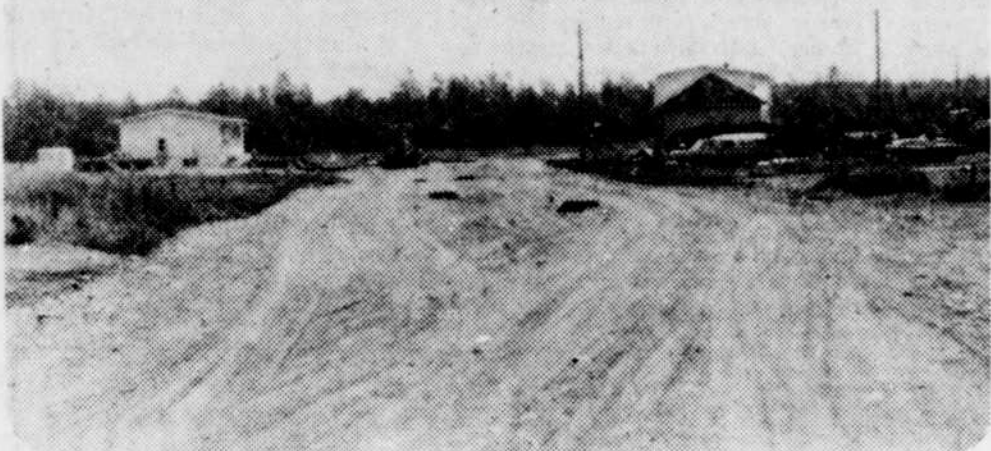
Un aperçu du chantier du futur "Domaine Saint-Michel" où il y a déjà trois maisons de construites.
