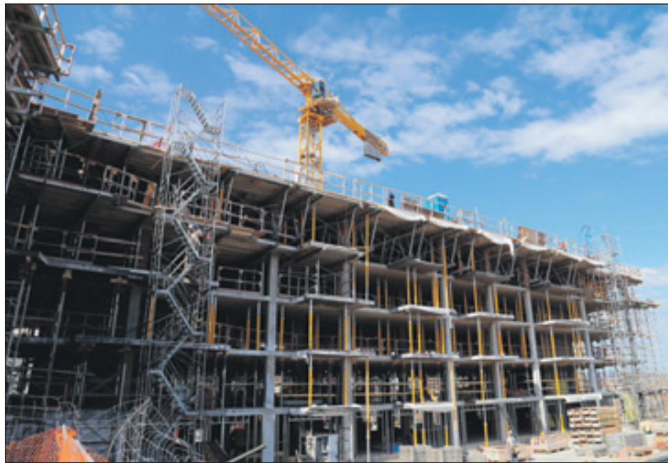
Les charpentes, composées entièrement de béton des deux édifices composant le Complexe La Garde offrent à leurs occupants une insonorisation maximale.
