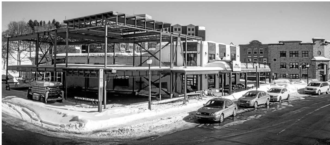
En novembre 2016, la Ville de Shawinigan a accordé un permis pour des travaux d'agrandissement estimés à 500 000 $ au Bistro Saint-Mo, où les travaux sont en cours sur la Promenade du Saint-Maurice. — PHOTO: FRANÇOIS GERVAIS
