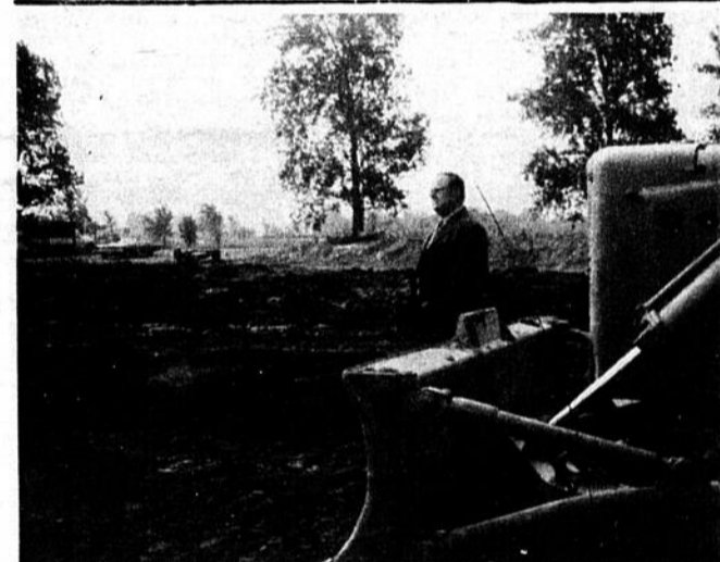
Les travaux ont débuté chez MOND BEC INC. à Farnham en vue de l'érection d'un centre de récréation.
