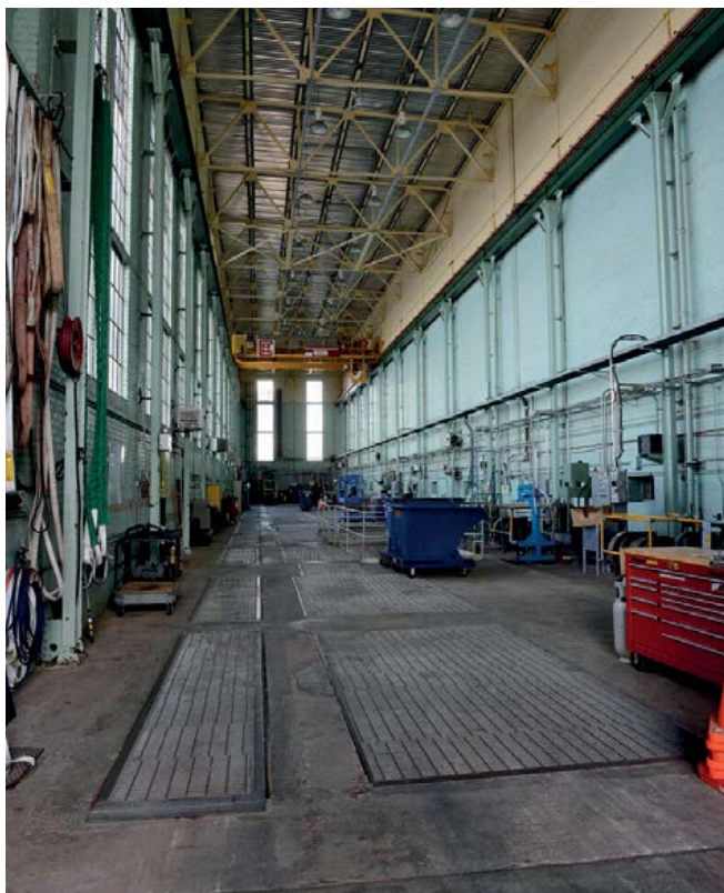
La prise d'eau a subi peu de modifications depuis sa construction, mis à part l'obturation des fenêtres les plus basses après les embâcles du printemps 1945. De plus, les murs de briques et les poutres d'acier ont été peints.
