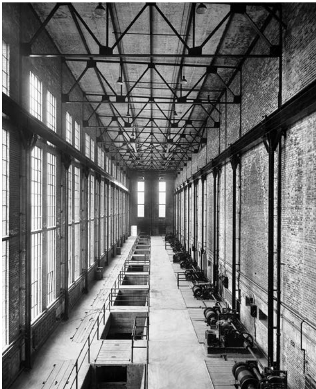
La prise d'eau se situe en amont de la centrale (photo prise vers 1925).
