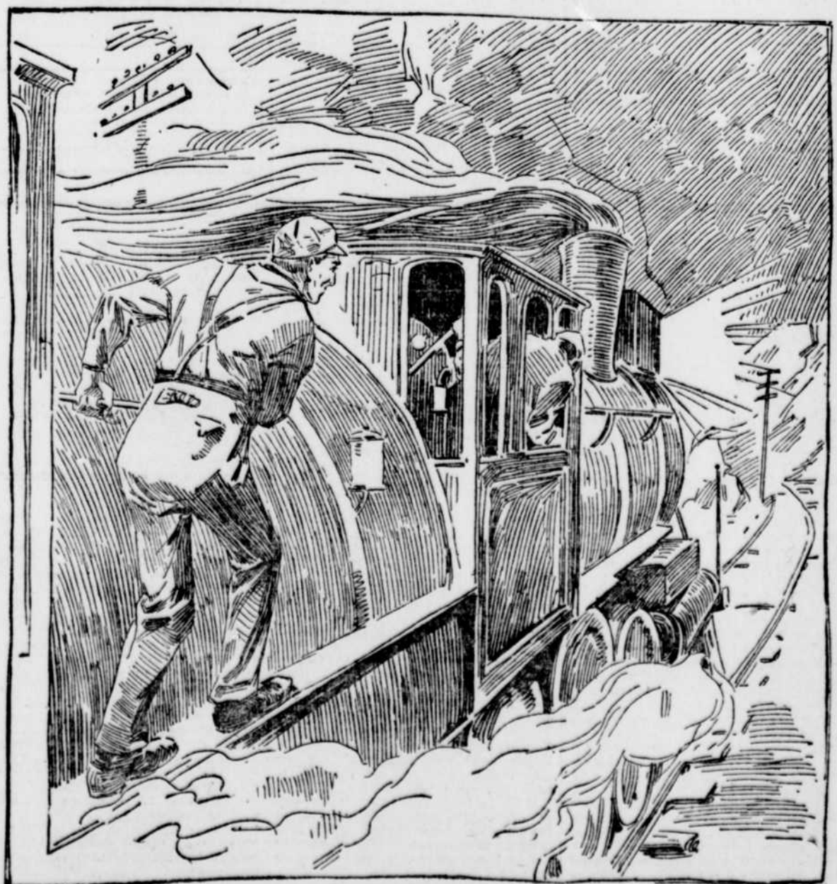
LES VICTIMES DU DEVOIR.—Un mécanicien et son chauffeur restent à leur poste et trouvent la mort en tentant avec succès de sauver les passagers d'un train express mis en danger par un éboulement qui barrait la voie.
