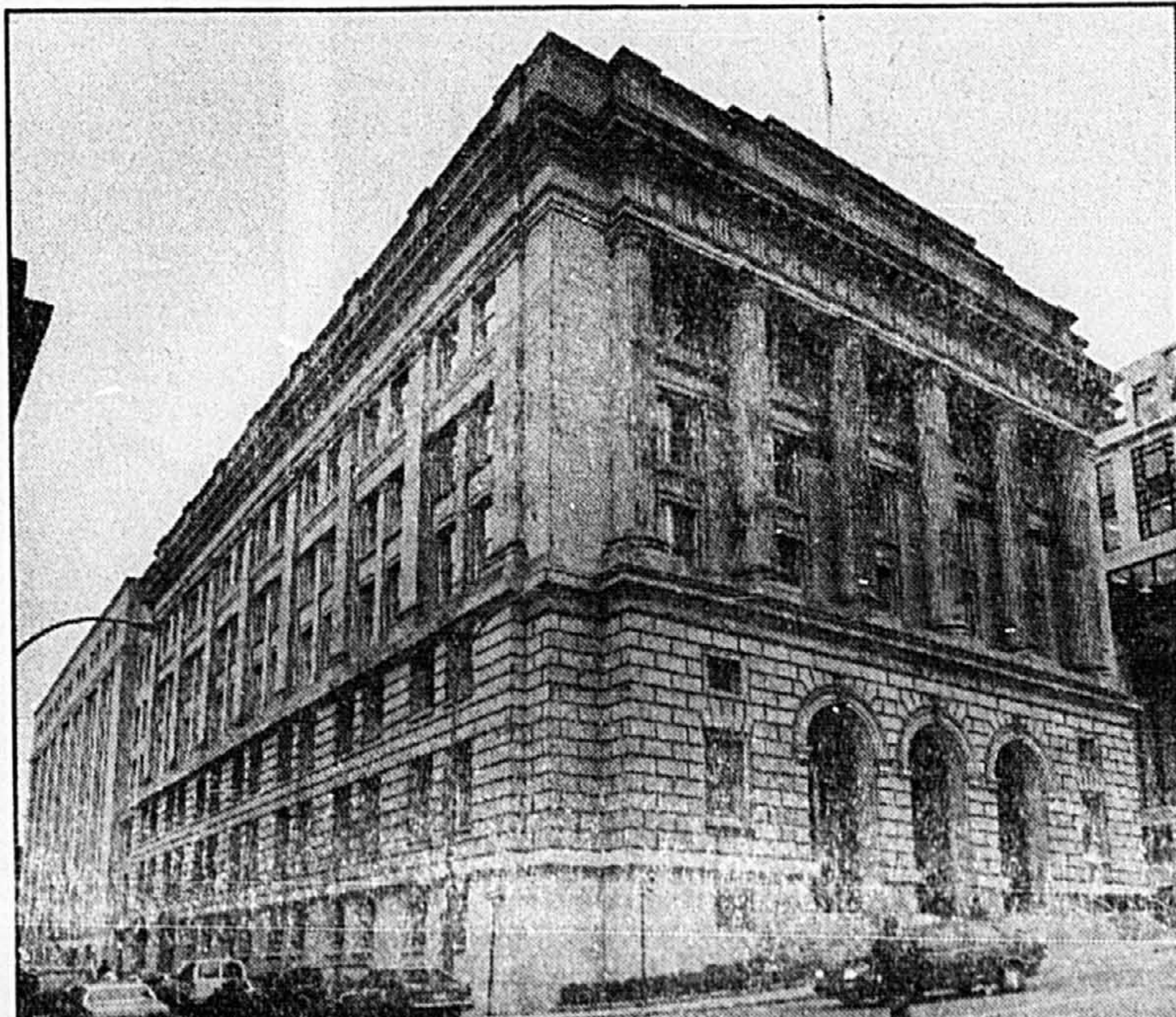
L'annexe vue du nord-ouest, à l'angle des rues Saint-Louis et Gosford
