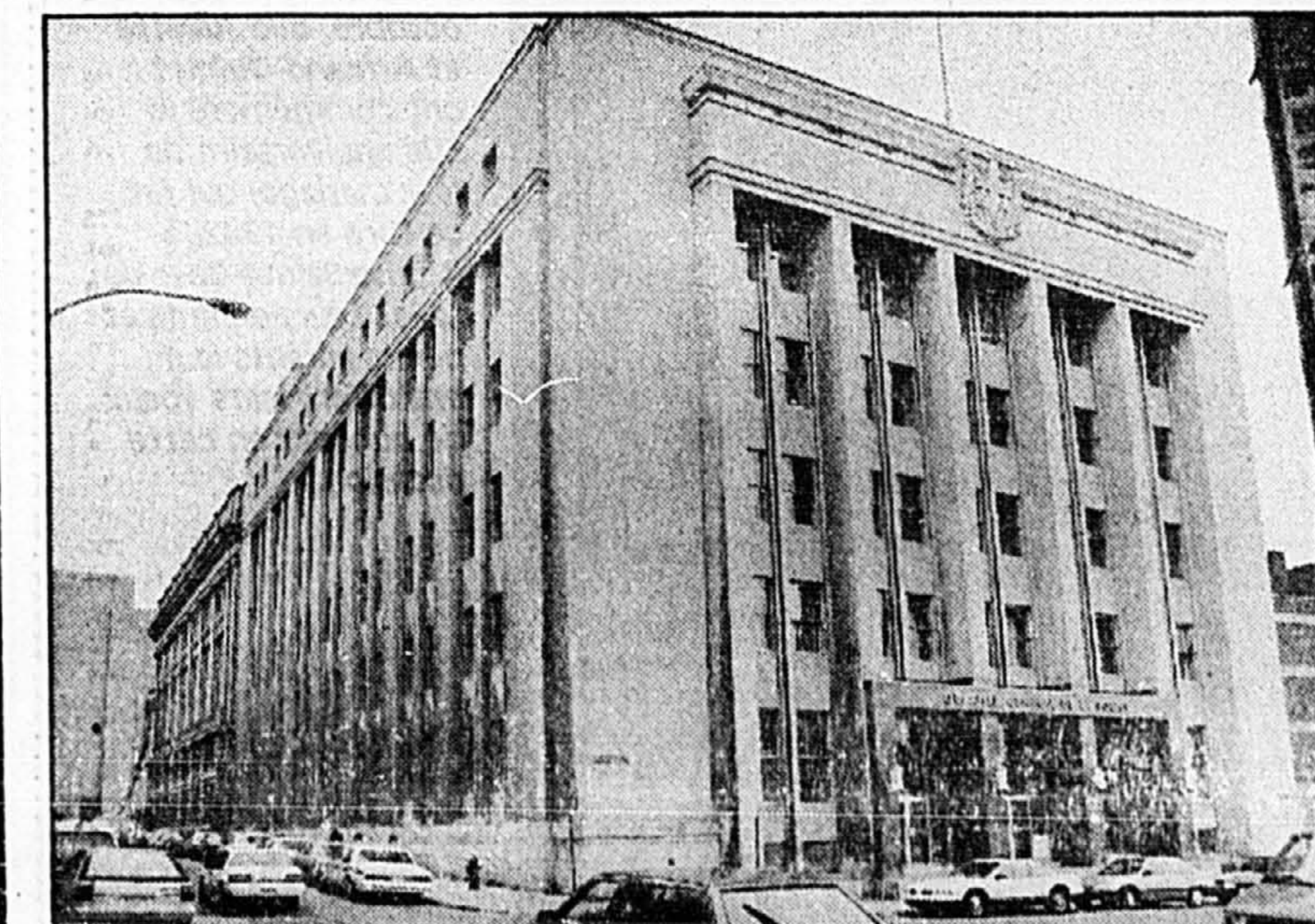
La façade de la rue Bonsecours, vue du sud-est, à l'angle des rues du Champ-de-Mars et Bonsecours.
