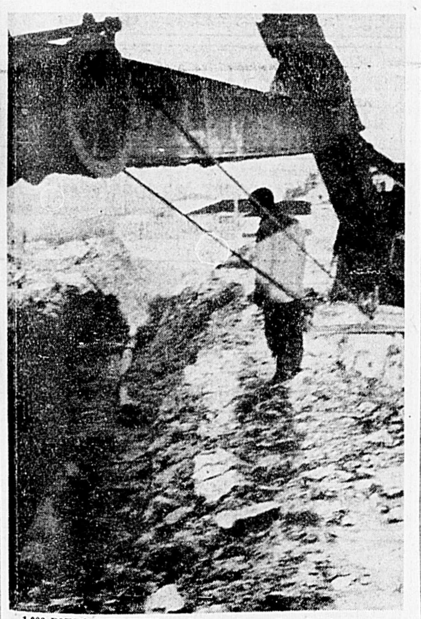
1,000 PIEDS D'EGOUTS. — Cette grosse pelle mécanique creuse ici un canal de 1,000 pieds de longueur en vue de l'installation des égouts et de l'aqueduc sur la rue Bolly, à Chicoutimi. Le prolongement de la rue Bolly permettra de commencer sous peu de nouvelles constructions dans cette partie de la ville. Plus d'une quarantaine de maisons seront desservies par les services municipaux. (Photo Tess.)
