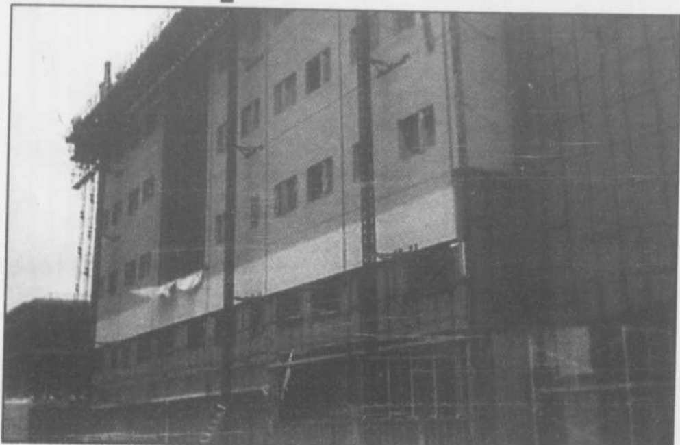
Le bloc C (urgence) en construction.
