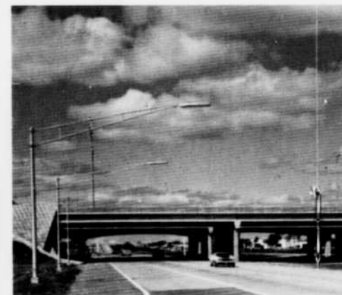
5. Viaduc de béton au croisement des ro
