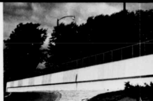
3. Un mur de soutènement solide et résistant.
