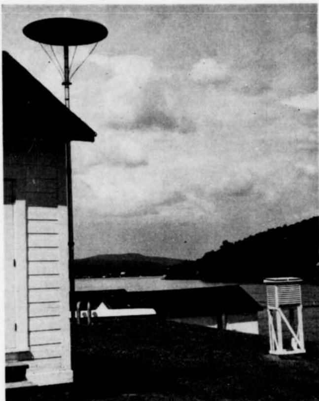
Figure 4 — Antenne du transmetteur DCP et abri météorologique installés à Duchesnay près du lac Saint-Joseph.
