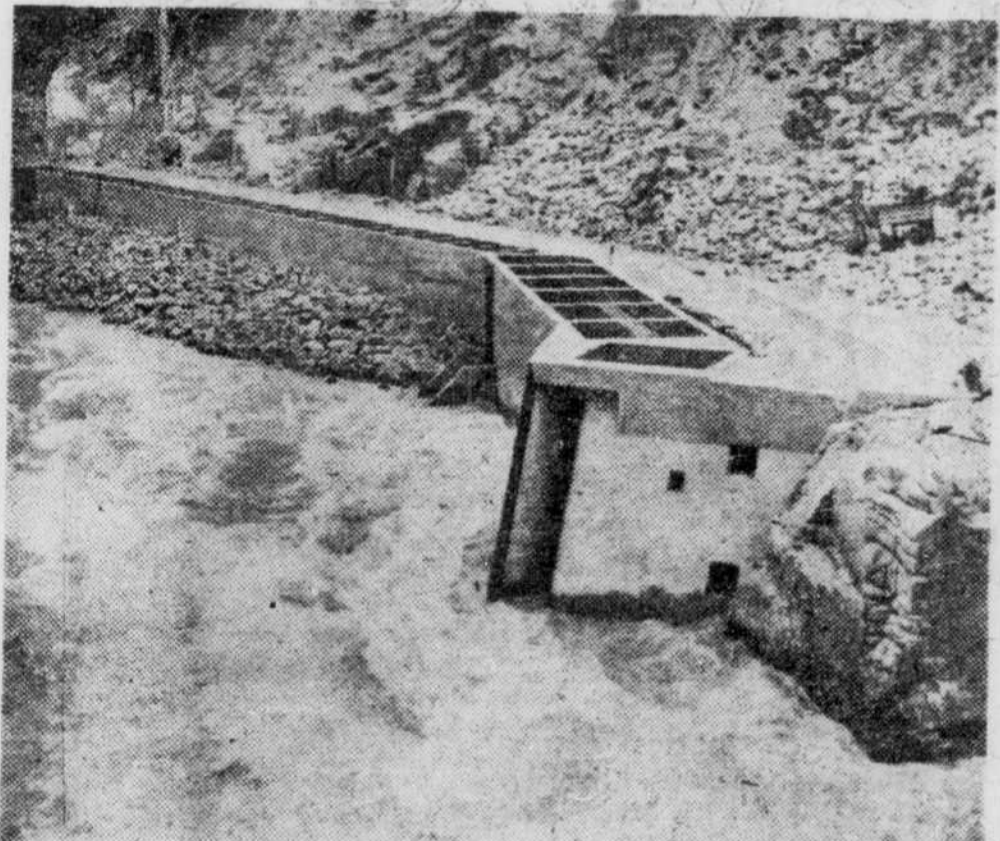
Les passes migratoires, à marée haute, sur la rive sud de la Porte de l'Enfer (Hell's Gate).
