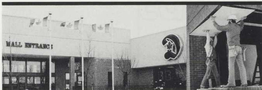
Parement Granex à Shoppers World, Brampton, Ontario.
