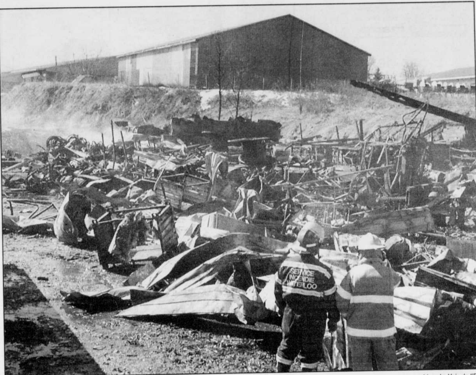
L'entrepôt Fer et métaux Papineau a été rasé le 4 avril.
