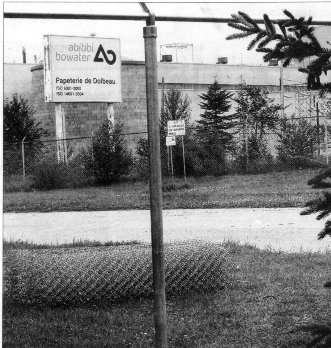
Les travaux pour clôturer l'usine ont débuté tôt lundi et devraient se poursuivre cette semaine.
