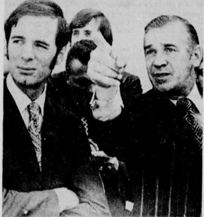
Le directeur intérimaire du Centre de détention d'Orsainville, M. Phil. Lemay, explique aux membres de la presse l'installation de spirales de barbelés qui remplaceront désormais l'armature inclinée au sommet d'une clôture de 22 pieds entourant l'enceinte extérieure de la prison.
