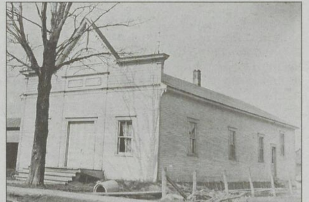
La salle municipale, bâtie vers 1900 par le Cercle Choral, fut vendue à la paroisse de Saint-Damase au montant de 800 $ en 1911. Cette salle située au 170 rue Principale, a subi plusieurs transformations pour être aujourd'hui une résidence privée.
