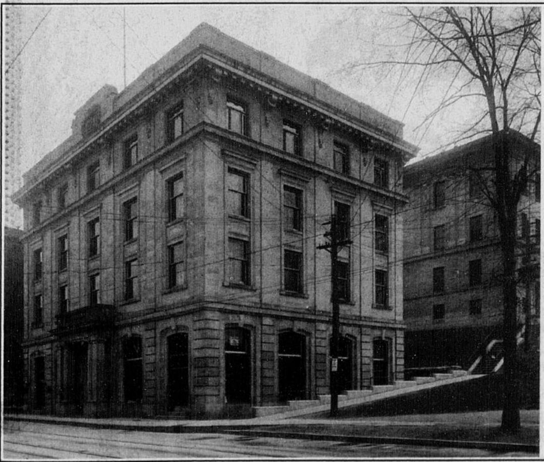
Édifice du Québec Central Railway, en 1938, situé sur la rue Wellington Nord.
