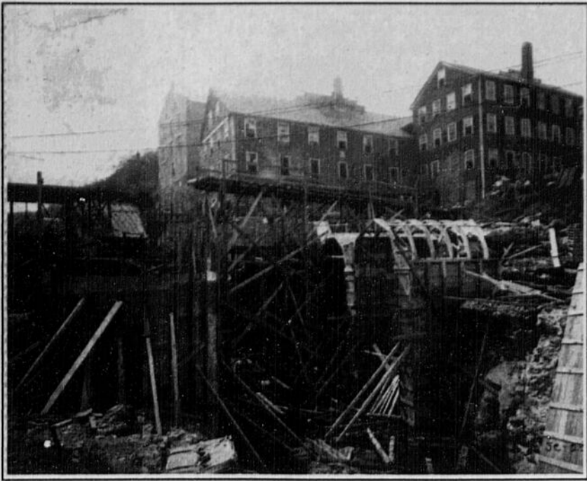
Construction des fondations de la centrale électrique Sherbrooke situé en bordure de la rivière Magog. (Fonds Hydro-Québec. La Société d'histoire de Sherbrooke)
