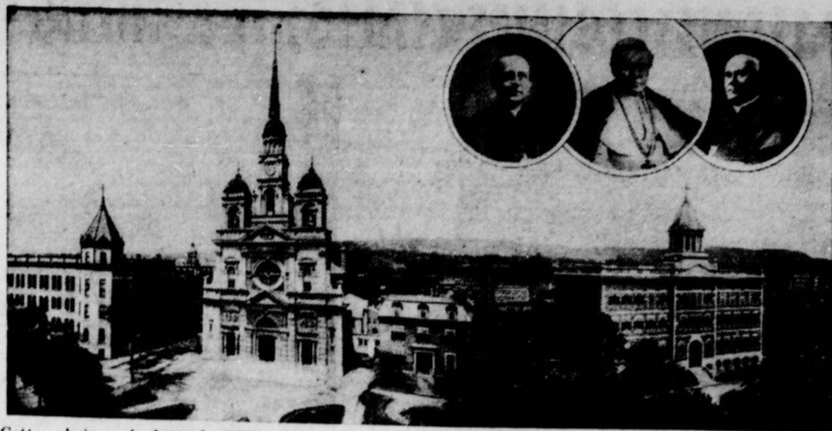
Cette photo qui date de 1914 nous montre les trois principaux édifices religieux de Saint-Henri, à cette époque.
