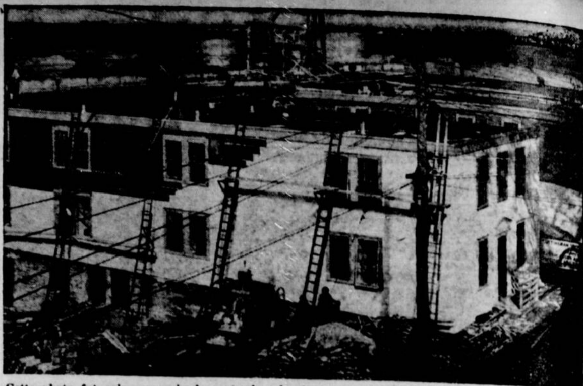
Cette photo fut prise au mois de septembre dernier, au cours de la construction de l'hôtel qui a brûlé pendant la soirée, samedi, à Sorel. On sait que cet édifice, comprenant 125 chambres, avait été érigé en un mois seulement, à l'aide de 630 panneaux, afin de loger les techniciens et les ouvriers employés aux industries de guerre. (Photo du "Petit Journal").
