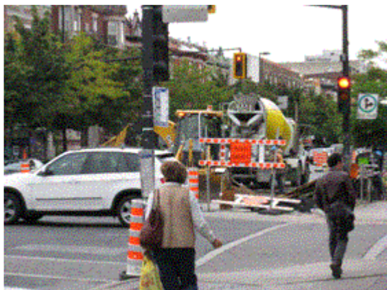
Photo 10. Intersection en construction (du Parc et Saint-Viateur)
