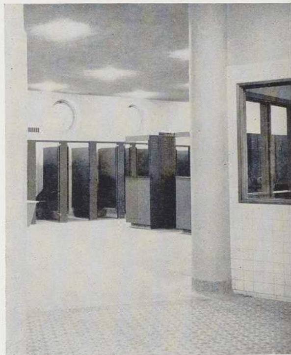
Vestiaire et douches. Parquets du vestiaire en ferrozso; ceux des douches en tuile céramique anti-dérapante.
