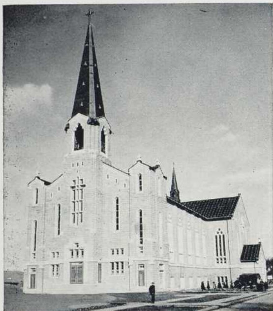
48,000 livres de tôles de cuivre furent utilisées pour couvrir le toit de la magnifique église de St-Thomas de Montmagny. Ce toit durera indéfiniment.
