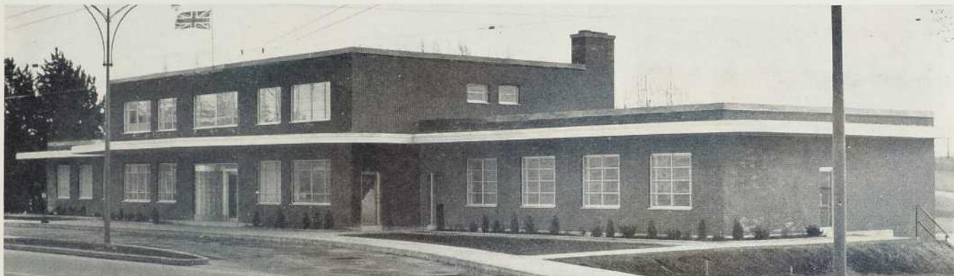
EDIFICE STREET RAILWAY TERMINAL — D'une superficie de 17,000 pieds carrés, cet édifice comprend un grand restaurant avec deux cuisines, une salle d'attente, 9 bureaux d'administration, un vaste auditorium et une salle de repos, ainsi que salle de jeux, toilettes, douches et vestiaires pour les chauffeurs d'autobus. Tout l'édifice est chauffé efficacement et économiquement avec trois unités Gar Wood.
