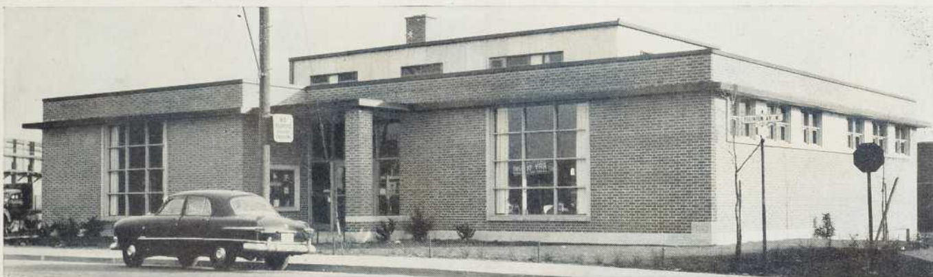
Bibliothèque chauffée à l'aide de Gar Wood. Une de plusieurs où l'on a installé Gar Wood. Architecte : Albert E. Vine. Dimensions : 75' x 80'. Très vaste sous-sol. Premier plancher — Salles pour les enfants et les élèves des écoles supérieures, salles de lectures et entrepôt. Deuxième plancher — Bureaux et entrepôt. Garage chauffé.
