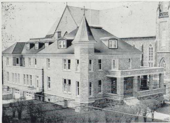
Paroisse St-Frédéric de Drummondville, Qué. La toiture du nouveau presbytère a nécessité 4,000 livres de tôles de cuivre. Entrepreneur: Conrad Joyal, Drummondville, Qué. L'architecte, David Deshaies, Nicolet, Qué.
