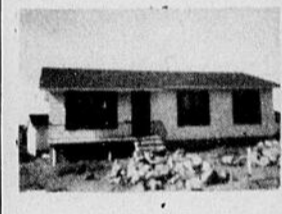
735 rue des Prés Vert Pointe-au-Père. Bungalow en construction - éligible aux ristournes fédérale.
