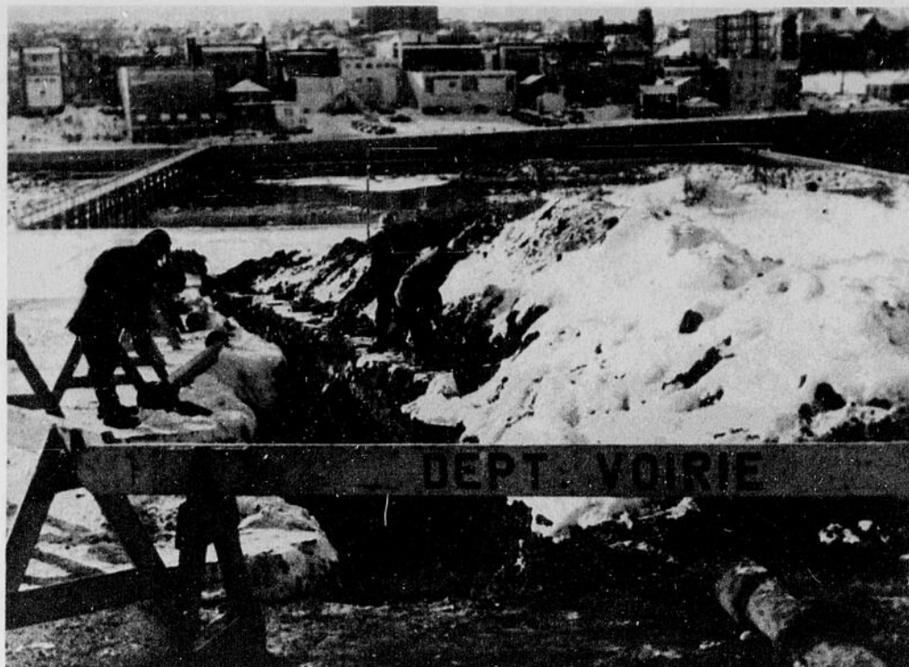
Les travaux d'hiver sont commencés dans la Petite-Décharge, à Alma. On voit ici des ouvriers qui sont à aménager une conduite d'aqueduc de 6 pouces pour alimenter le bassin de la fontaine lumineuse qui sera construit au cours de l'hiver afin d'éliminer tous les déchets de la rivière qui empêche la fontaine de fonctionner normalement.
