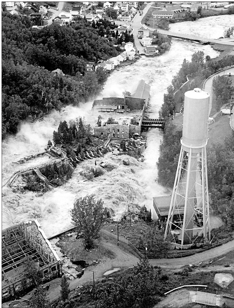
Lors du déluge au Saguenay en 1996, les trombes d'eau ont emporté 15 millions de mètres cubes de débris. — PHOTO D'ARCHIVES, LA PRESSE
