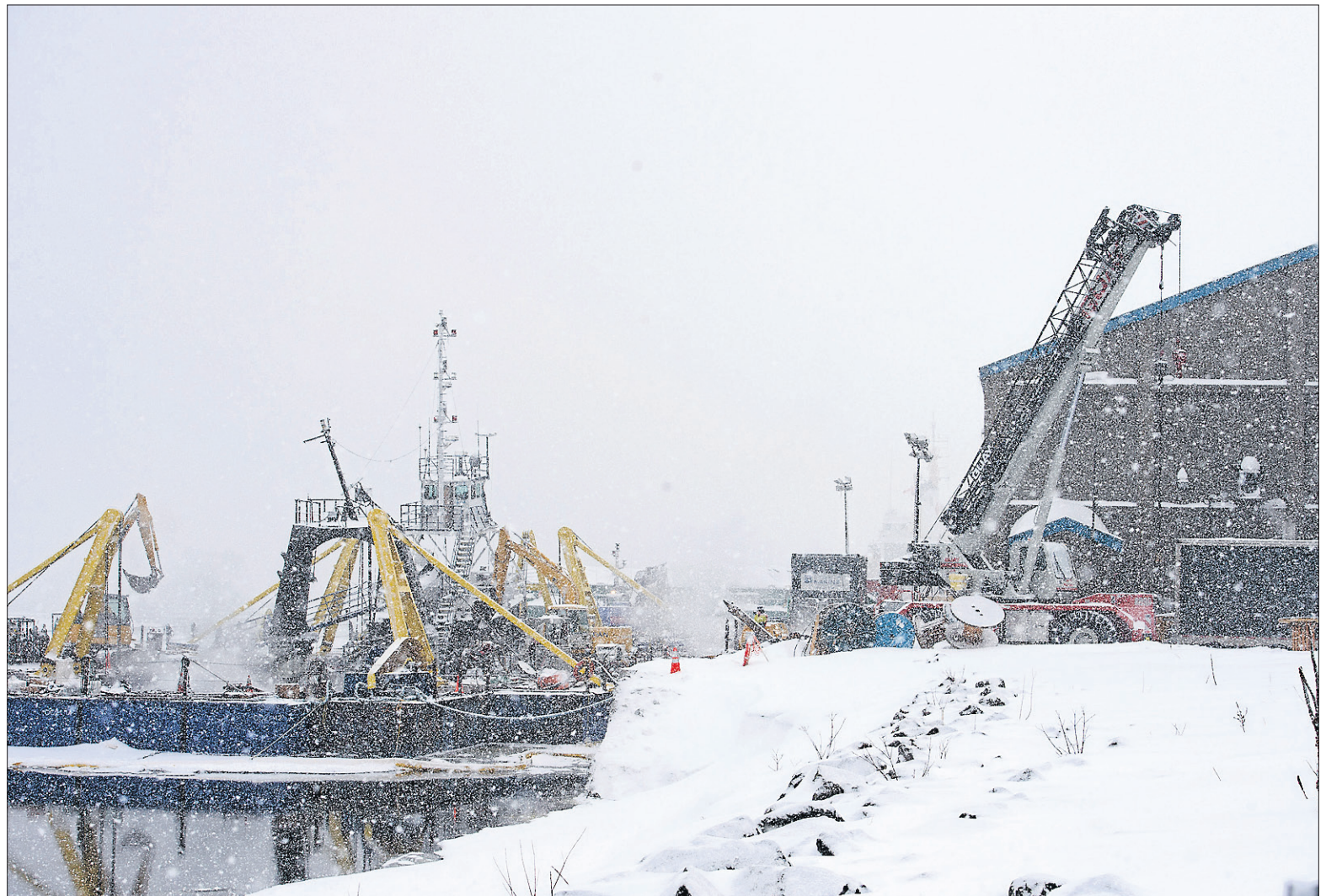
Après bien des délais, le renflouement du Chaulk Determination a finalement été amorcé hier, le devant du remorqueur commençant à sortir de l'eau. La prochaine étape consistera à monter l'arrière pour amener l'embarcation à la surface de l'eau. — PHOTO: STÉPHANE LESSARD
