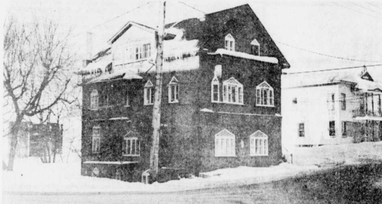
La maison qui deviendrait la "maison des citoyens" de Beauport.
