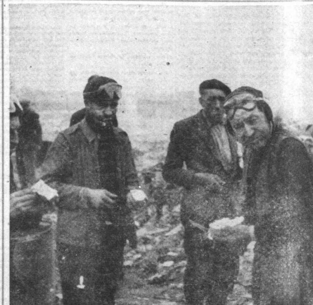
Cette photo a été prise sur les chantiers de construction de la Cité d'urgence. On y aperçoit quelques Chiffonniers en train de casser la croûte avant de reprendre le travail. (Photo Roland Bonnet)
