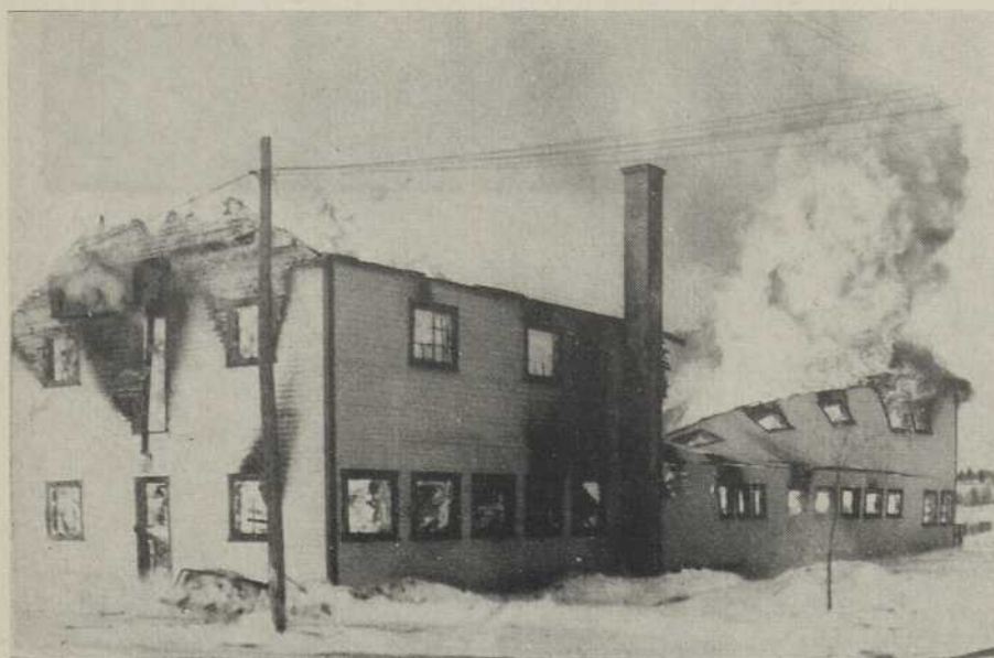
Cette saisissante photo a été prise après la chute du toit, au moment où l'un des murs s'effondrait. On peut facilement juger de la violence de l'incendie par le jet de flammes qui s'échappe près de la cheminée.
