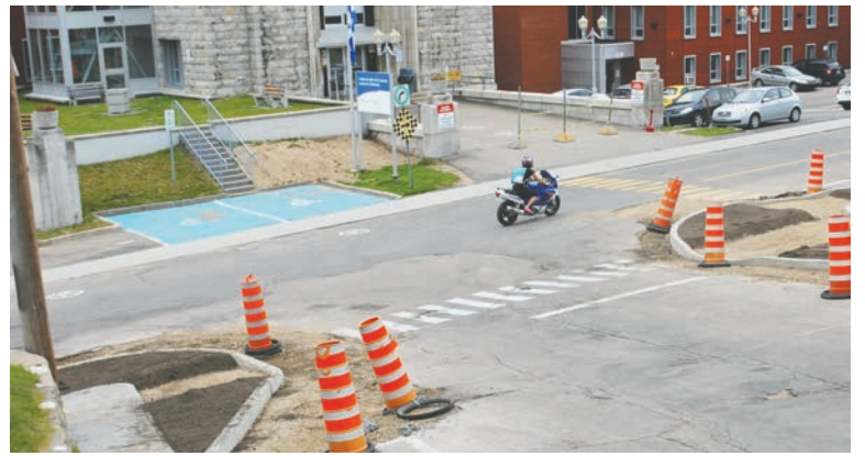
La traverse devant l'hôpital fait actuellement l'objet de travaux.
