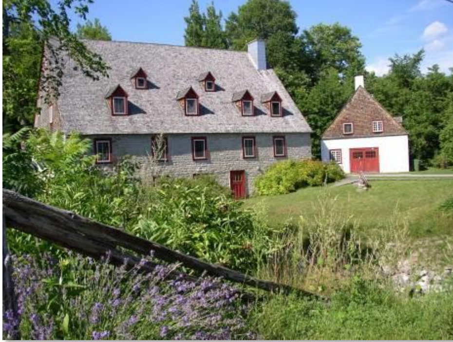
Les deux moulins de la Chevrotière à Deschambault. Au moment du contrat seul le petit à droite est existant. Les travaux pour construire le second débutent en 1802. Photo : Robert Marchand
