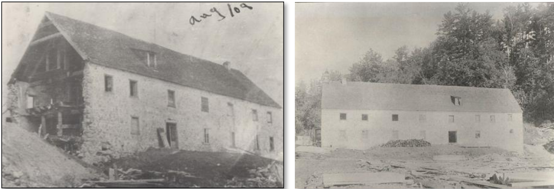
Deux vues d'un moulin aux environs de Cap-Santé.
