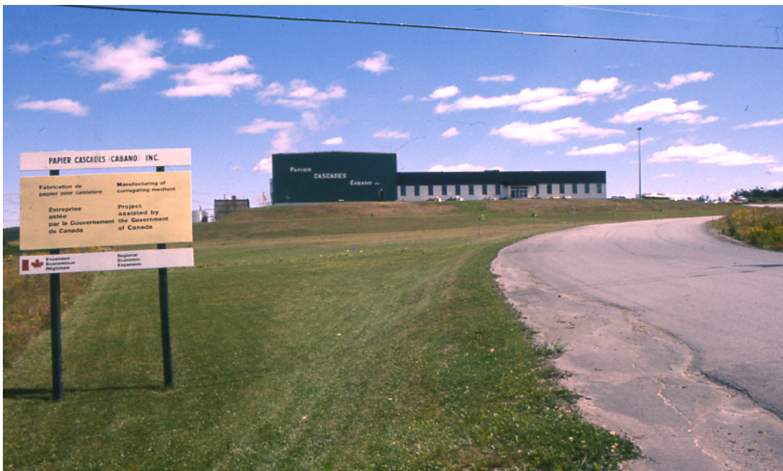
Figure 7 L'usine initiale en 1976
