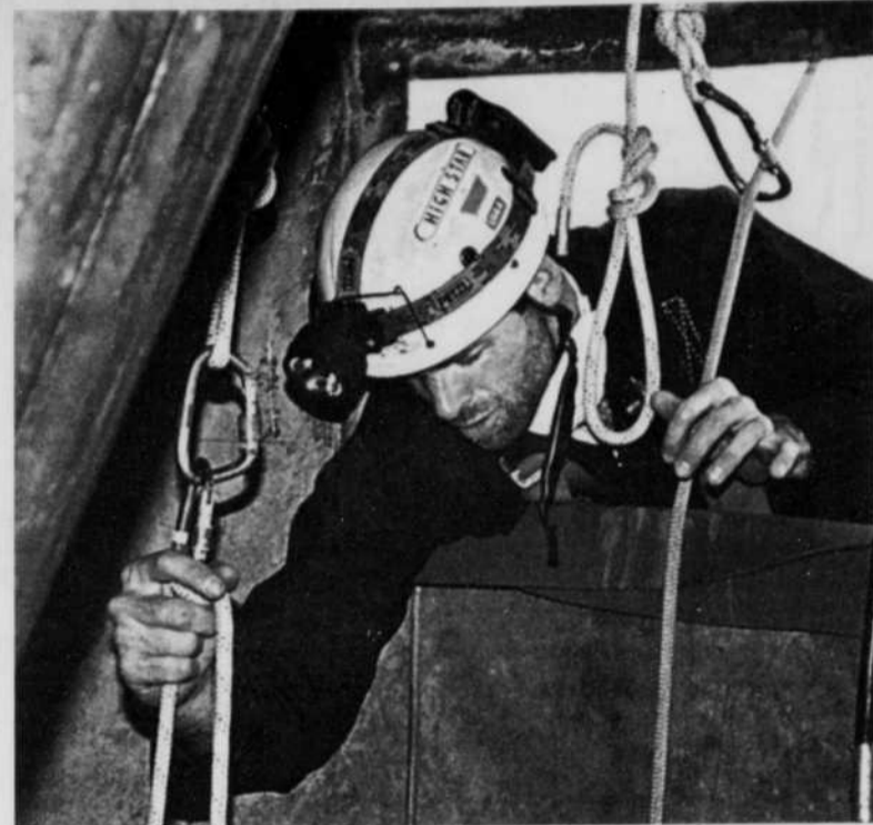
CHEMINÉE - Pour descendre dans une cheminée de 250 pieds de haut, les travailleurs d'Horizon Vertical, spécialisés dans l'escalade, utilisent des cordes. Ici, Joël Tremblay.
