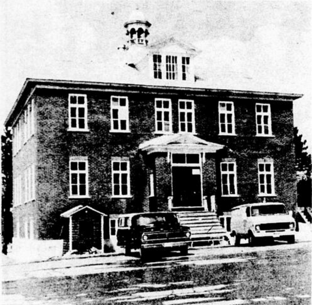
Le Vieux Collège de St-Paul se transforme en complexe communautaire. L'extérieur sera repeint, les escaliers rendus plus fonctionnels pour les malades, personnes âgées et handicapés si possible.
