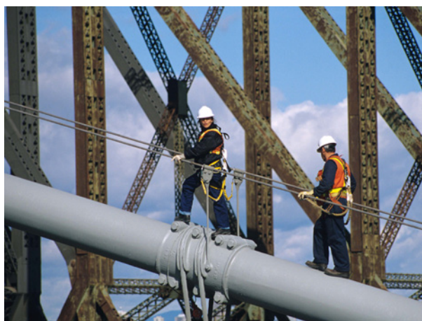
P-04296 Inspecteurs circulant sur les câbles porteurs du Pont Pierre-Laporte
