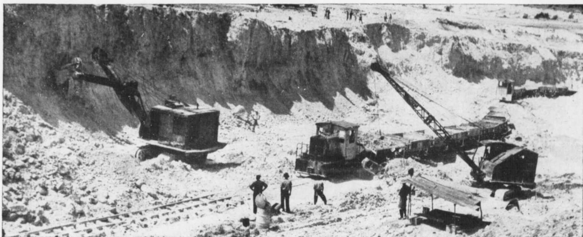
La bauxite est extraite en Guyane anglaise. Cette argile rougeâtre est le minerai principal dans la production de l'aluminium. De la Guyane anglaise la bauxite est expédiée par bateau à Port-Alfred, situé sur la rivière Saguenay. De cet endroit le minerai est chargé sur des wagons et transporté aux usines d'Arvida, le plus grand centre d'aluminium au monde. Ainsi la bauxite, soumise au procédé électrolytique, se fusionne et on obtient l'aluminium.
