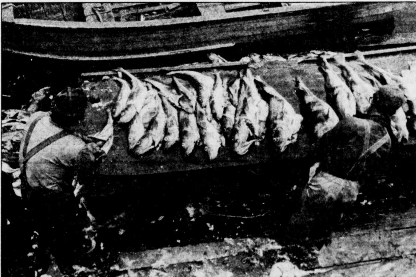
Une campagne qui n'apporte rien de concret sur la stabilité économique de la Gaspésie, reliée en grande partie à l'industrie des pêcheries.
