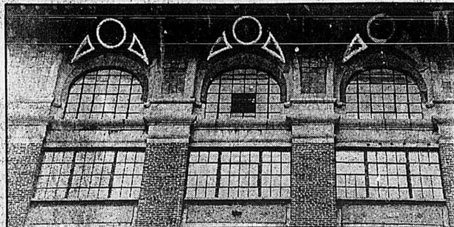
La remarquable corniche de l'attique
