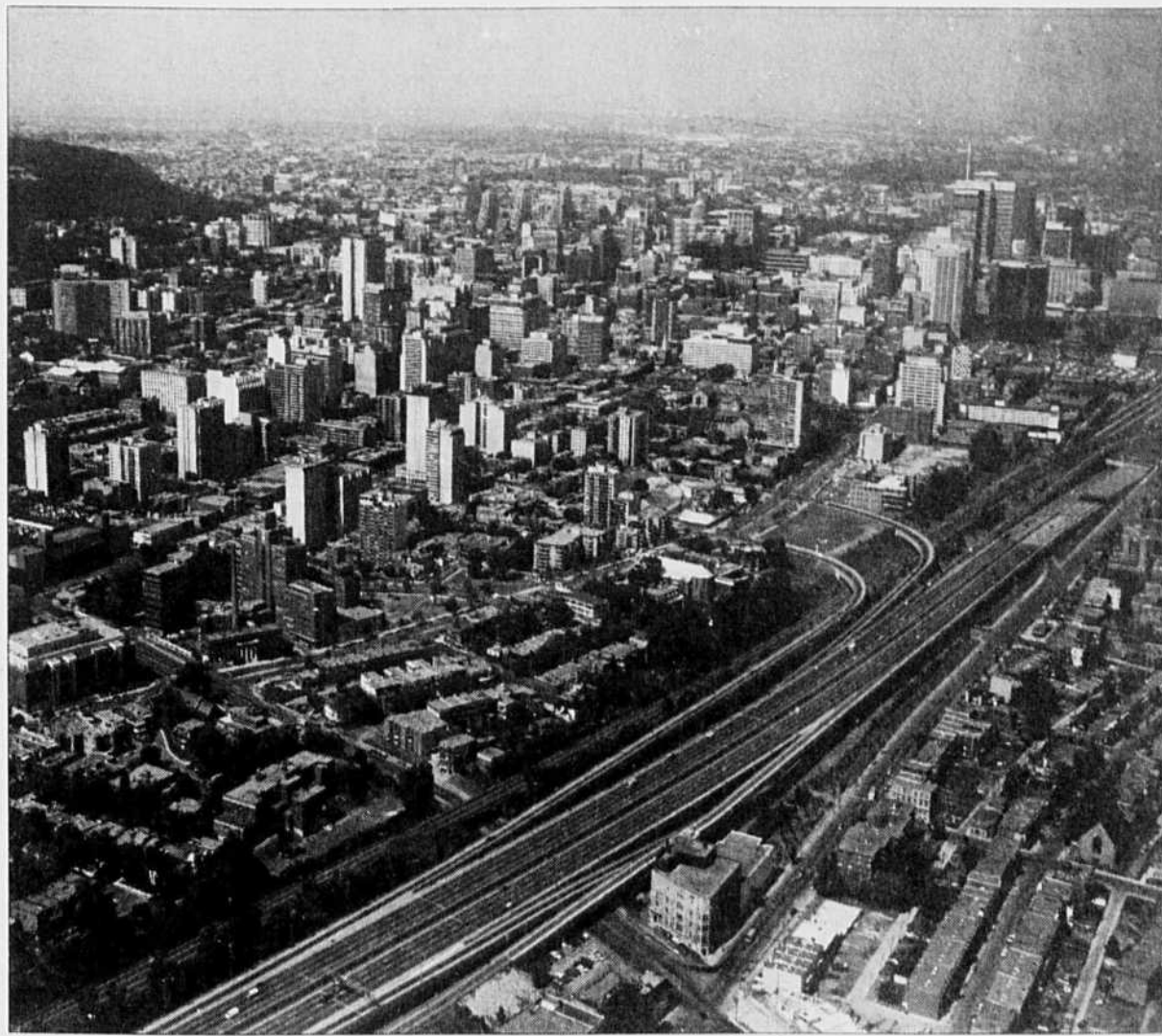
Une vue de l'autoroute Ville-Marie en direction du centre-ville de Montréal.
