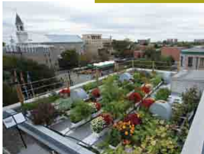
UN JARDIN COUVRE LE TOIT DE LA CAISSE POPULAIRE DESJARDINS DU MONT-ROYAL DEPUIS MAI 2010
