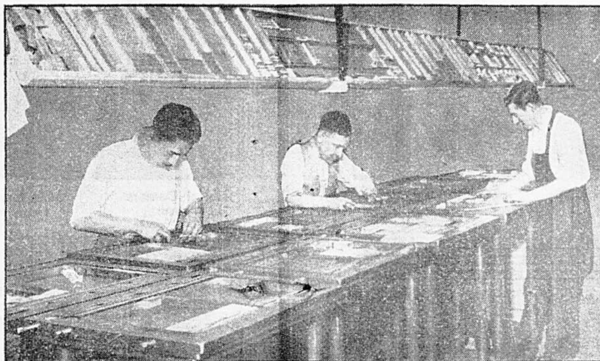
5 LA MISE EN PAGE.— Les lignes de plomb produites par la linotype sont "mises en page", c'est-à-dire, déposées dans des cadres ayant exactement la forme d'une page de journal.
